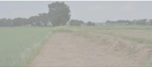
Oberbodenabtrag Quelle: Björn Rohloff
