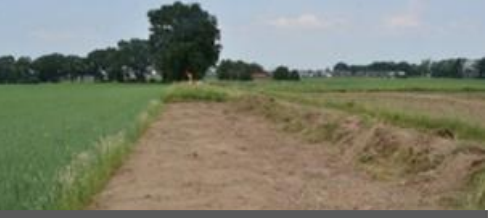
Oberbodenabtrag Quelle: Björn Rohloff
