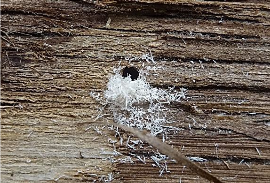
Abbildung 2: Ausbohrloch mit Bohrspänen, © M. Noack, LELF
